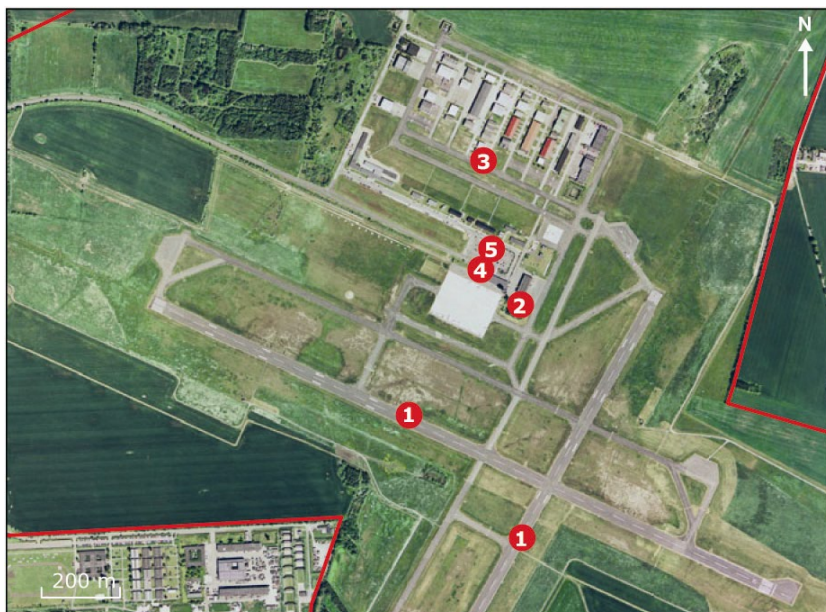
Figur 2-2: Lufthavnens faciliteter: (1) Manøvreområde med tilhørende rulleveje, (2) Forpladsområde med kontrolltårn, flystandpladser, tankanlæg og udstyr til at vedligeholde lufthavnen, (3) Hangarområde med værksteder og kontorer for private virksomheder og flyveskoler, (4) Terminalbygning med havnekontor, ventefaciliteter, cafeteria m.m., (5) Parkeringspladser.
